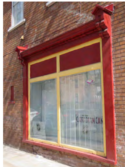
Fenêtre à battants à imposte et linteau en arc surbaissé. Corniche de vitrine avec consoles d'arrêt ornées. 1082-1096, 1 re Avenue. Photos : IMG_1983.jpg et IMG_1986.jpg
