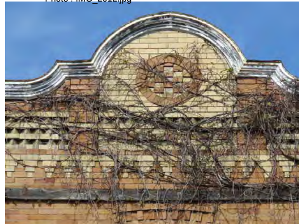
Couronnement en arc plein cintre et jeux de briques créés par des couleurs et des reliefs. 1174-1178, 1 re Avenue. Photo : IMG_2028.jpg
