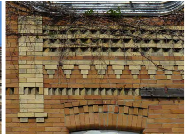
Jeux de briques créés par des briques en relief et de couleur différente de celle du mur. 1174-1178, 1 re Avenue. Photo : IMG_2029.jpg
