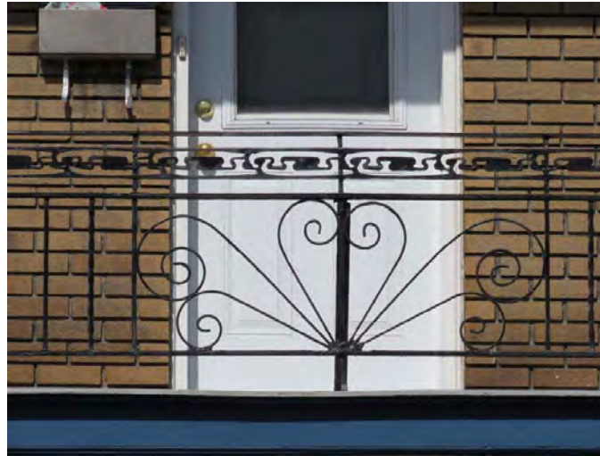
Garde-corps en fer ornemental, dont la partie supérieure est constituée de retailles de poinçonnage de lames de patins. 1146-1150, 1 re Avenue. Photo : IMG_2017.jpg
