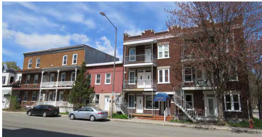
Corniche à modillons, corniche à ressauts et frontons. Côté est de la 1 re Avenue. De gauche à droite : les 800 à 840. Photo : IMG_1915.jpg
