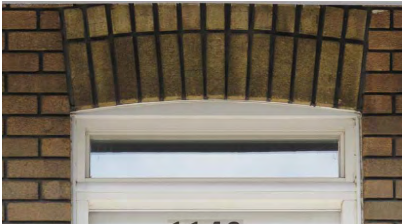
Imposte rectangulaire de porte et linteau en arc surbaissé. 1146-1150, 1 re Avenue. Photo : IMG_2018.jpg
