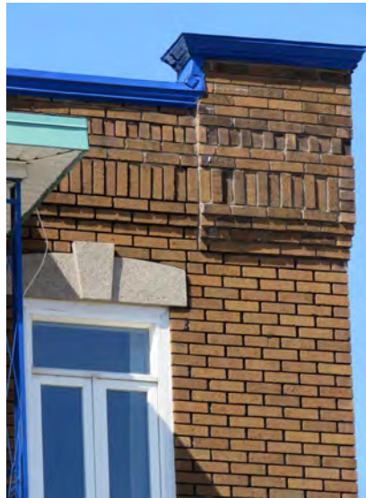
Linteau en pierre et amortissement en briques formant un relief. 1287-1297, 1 re Avenue. Photo : IMG_1841.jpg
