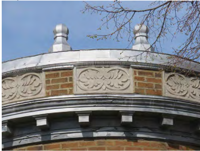
Incrustation de pierre sur un mur parapet avec urnes au sommet et modillons en dessous. 1210-1214, 1 re Avenue. Photo : IMG_2050.jpg
