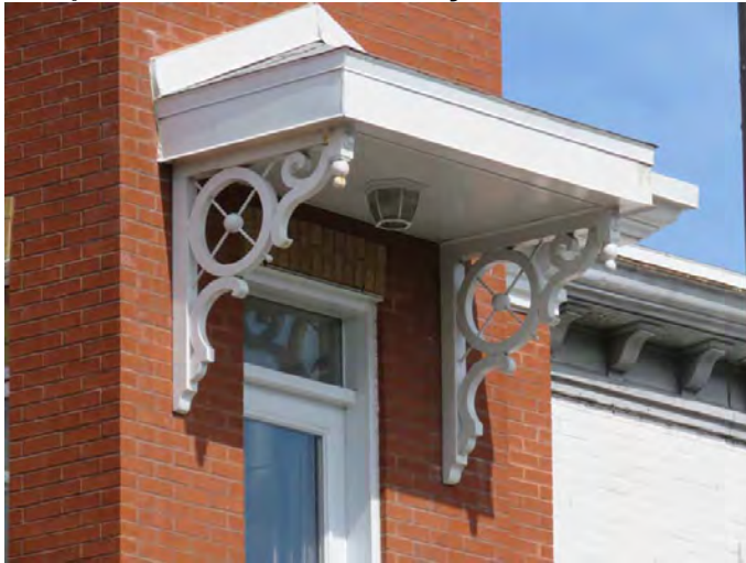
Consoles découpées en bois supportant le toit du balcon du dernier étage du 1072-1076, 1 re Avenue. Photo : IMG_1973.jpg
