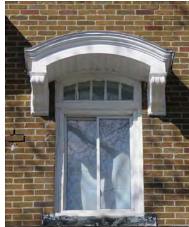
Exceptionnel toit arqué à consoles surplombant une fenêtre à imposte à arc surbaissé. 1715-1717, 1 re Avenue. Photo : IMG_1758.jpg
