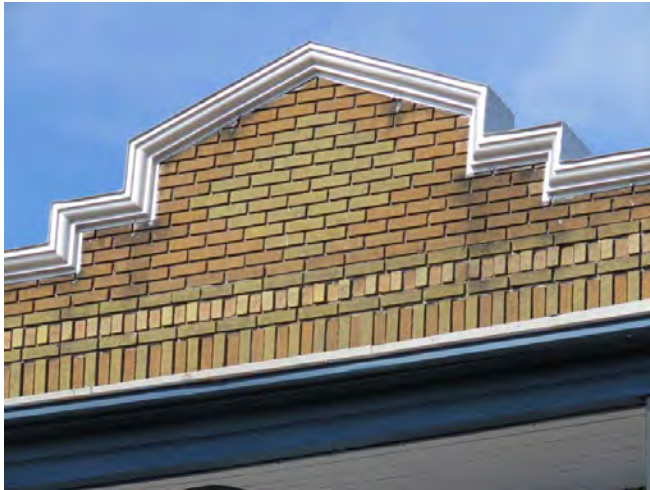
Fronton avec jeu de briques et corniche à ressauts. 1146-1150, 1 re Avenue. Photo : IMG_2011.jpg
