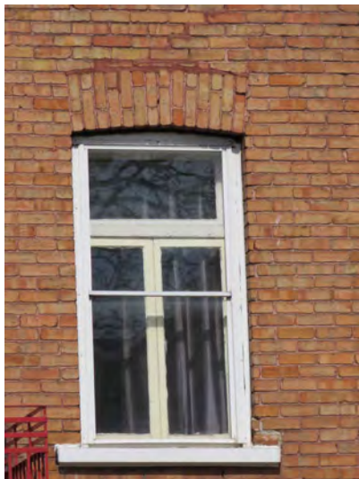
Fenêtre à battants à imposte et linteau en arc surbaissé. Corniche de vitrine avec consoles d'arrêt ornées. 1082-1096, 1 re Avenue. Photos : IMG_1983.jpg et IMG_1986.jpg
