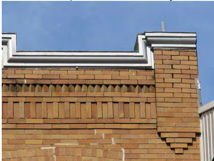
Jeux de briques, corniche à ressauts et amortissement disposé en relief (à l'extrême droite). 1268-1272, 1 re Avenue. Photo : IMG_2068.jpg
