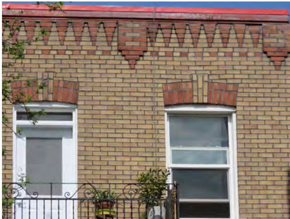
Jeux de briques créés par l'utilisation de briques en relief et de couleur différente de celle du mur. Sommet de la façade du 1026-1030, 1 re Avenue. Photo : IMG_1949.jpg
