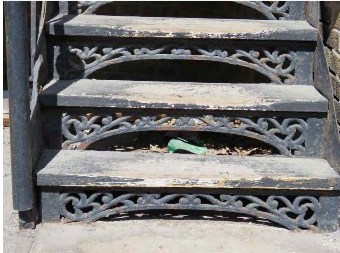
Contremarches en fonte. 1082-1096, 1 re Avenue. Photo : IMG_1997.jpg
